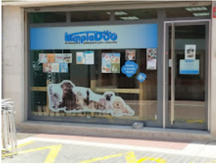
FACHADA 4.jpg 238K
