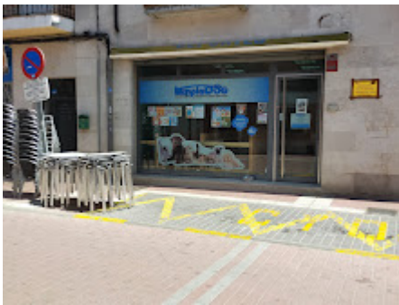
FACHADA 6.jpg 458K
